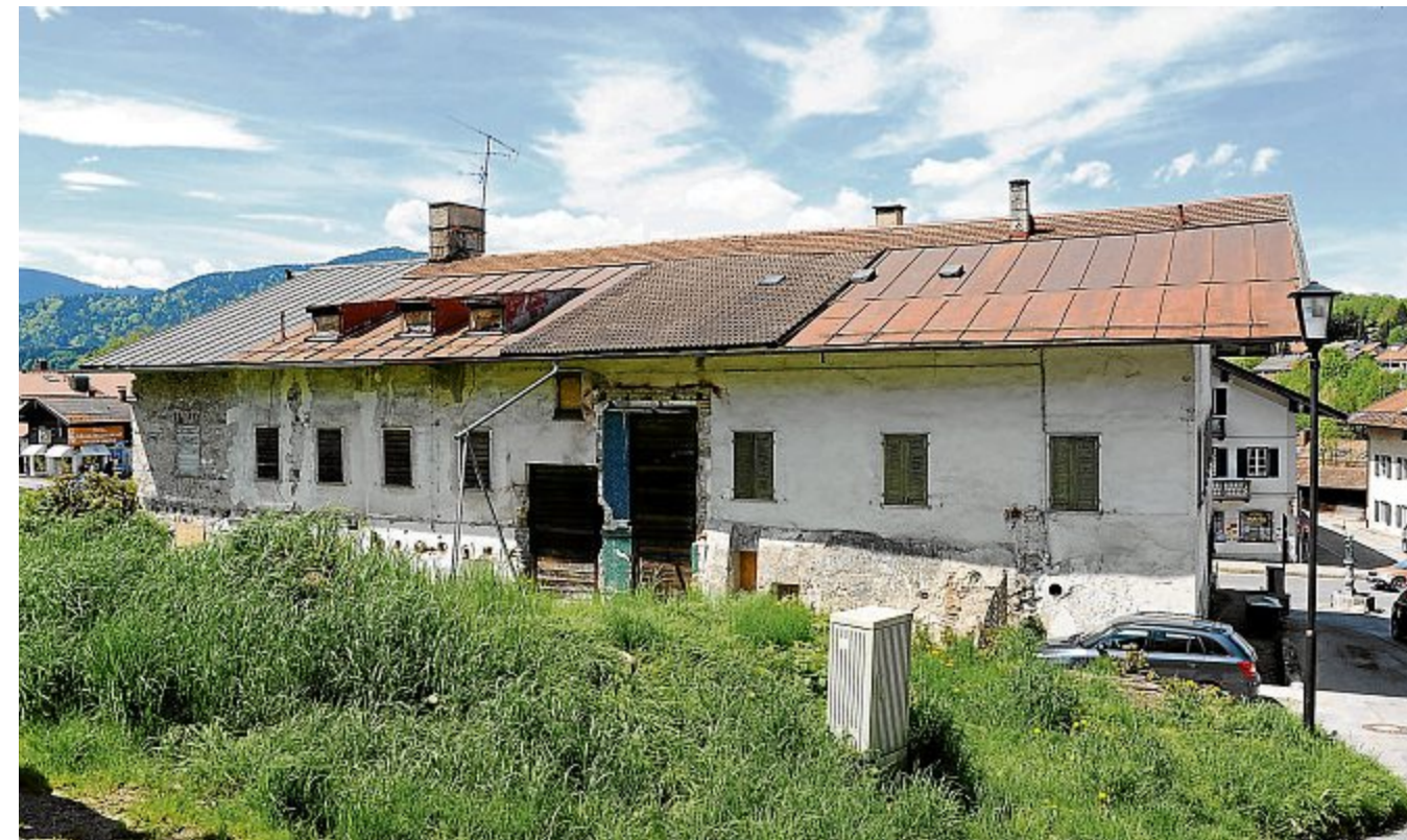
Desolater Zustand: der denkmalgeschützte Gasthof Maximilian in Gmund.
